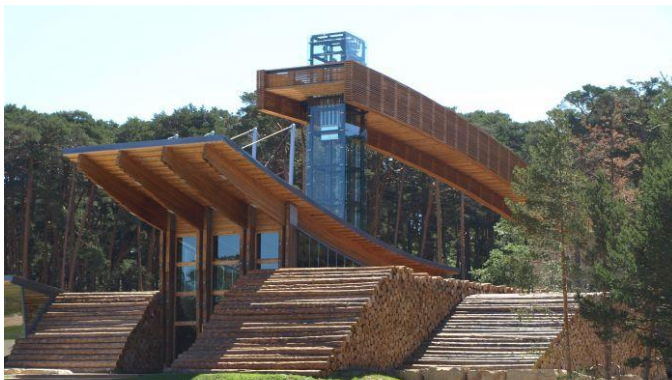
Construcción en madera en Argentina, ejemplo de Arquitectura Sostenible
